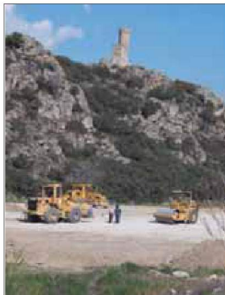
Máquinas trabajando en el futuro aparcamiento
