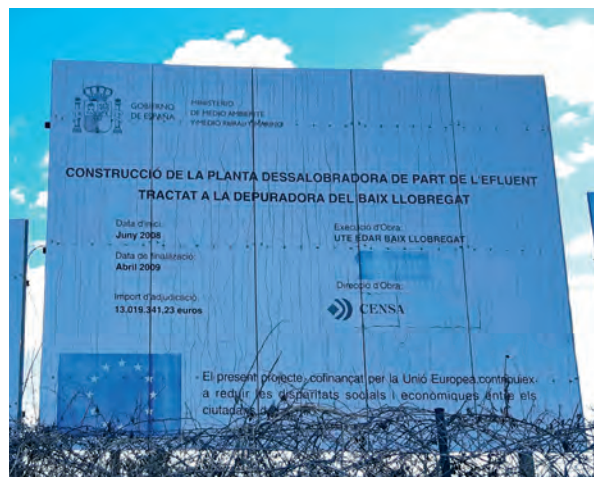
EL DESVENCIJADO CARTEL QUE AÚN ANUNCIA EL PROYECTO DE LA PLANTA
