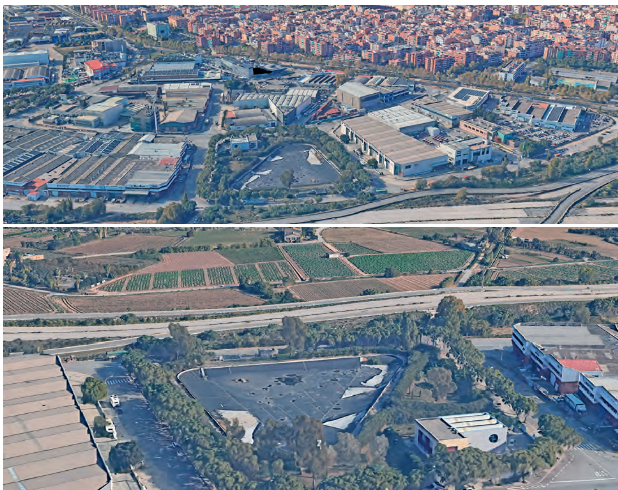
DOS PROYECCIONES DE LA Balsa INACABADA EN EL POLÍGONO LES SALINES DE SANT BOI EN LAS QUE PUEDE APRECIARSE SU DETERIORO (GOOGLE EARTH)
