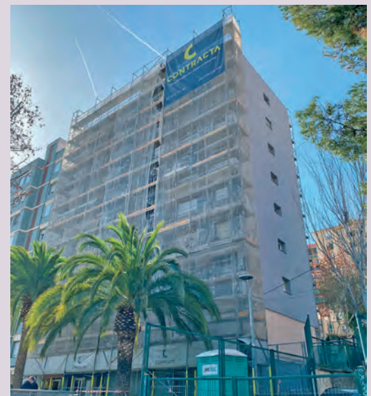
REHABILITACIÓN EN CURSO DEL EDIFICIO DE ISABEL LA CATÓLICA, 37
