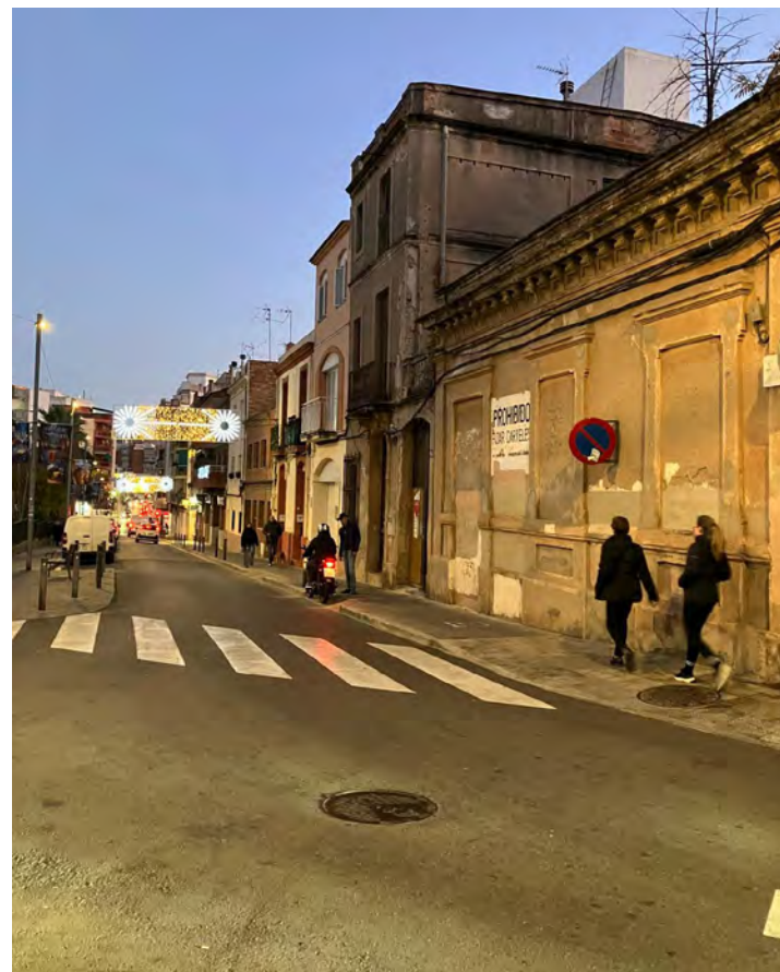
FACHADA LATERAL DE LA FINCA EN LA QUE SE LEVANTARÁ LA FUTURA BIBLIOTECA DE MARIANAO
