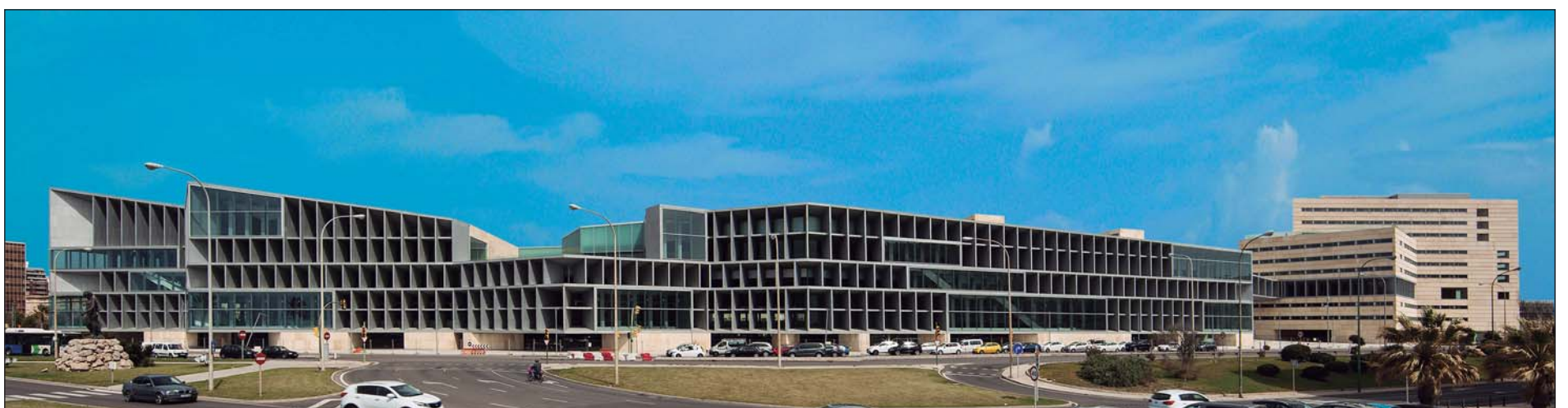
El Palacio de Congresos de Palma y el hotel Meliá Palma Bay están ubicados en el Paseo Marítimo de Palma, a pocos minutos del aeropuerto.
