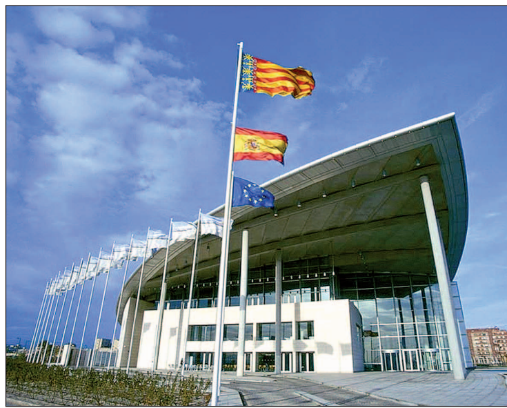
Fachada principal del Palacio de Congresos de Valencia.
