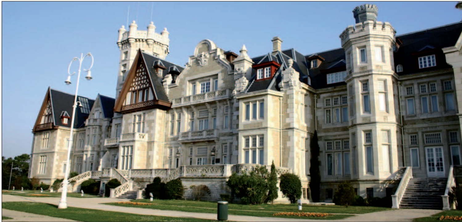
Las obras de remodelación del Palacio de la Magdalena van mejor de lo previsto y finalizarán el próximo 1 de junio.
