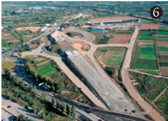
LA VARIANTE DE LA C-245, OTRO EPISODIO ROCAMBOLESCO DE INFRAESTRUCTURAS INACABAS EN EL BAIX | ARCHIVO
