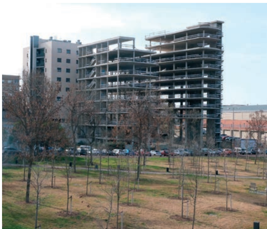
L'EDIFICI EXPROPIAT PER L'AJUNTAMENT DE SANT JOAN DESPÍ | AJUNTAMENT DE SANT JOAN DESPÍ
