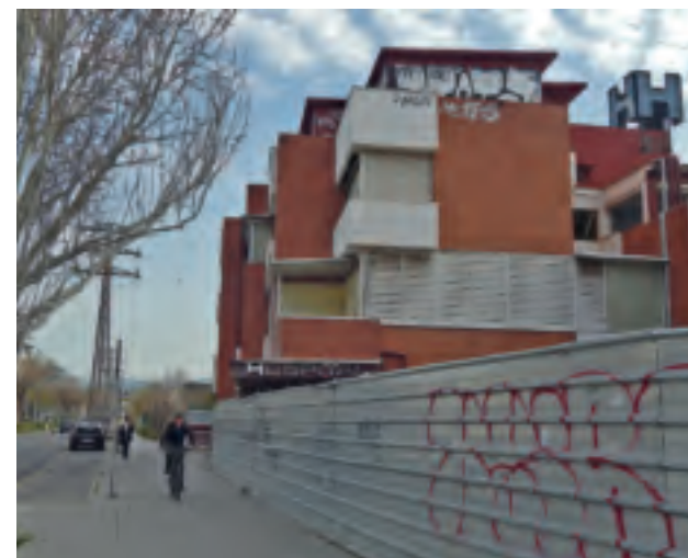
ANTIC HOSPITAL DE SANT BOI EN EVIDENTS MOSTRES D'ABANDONAMENT
