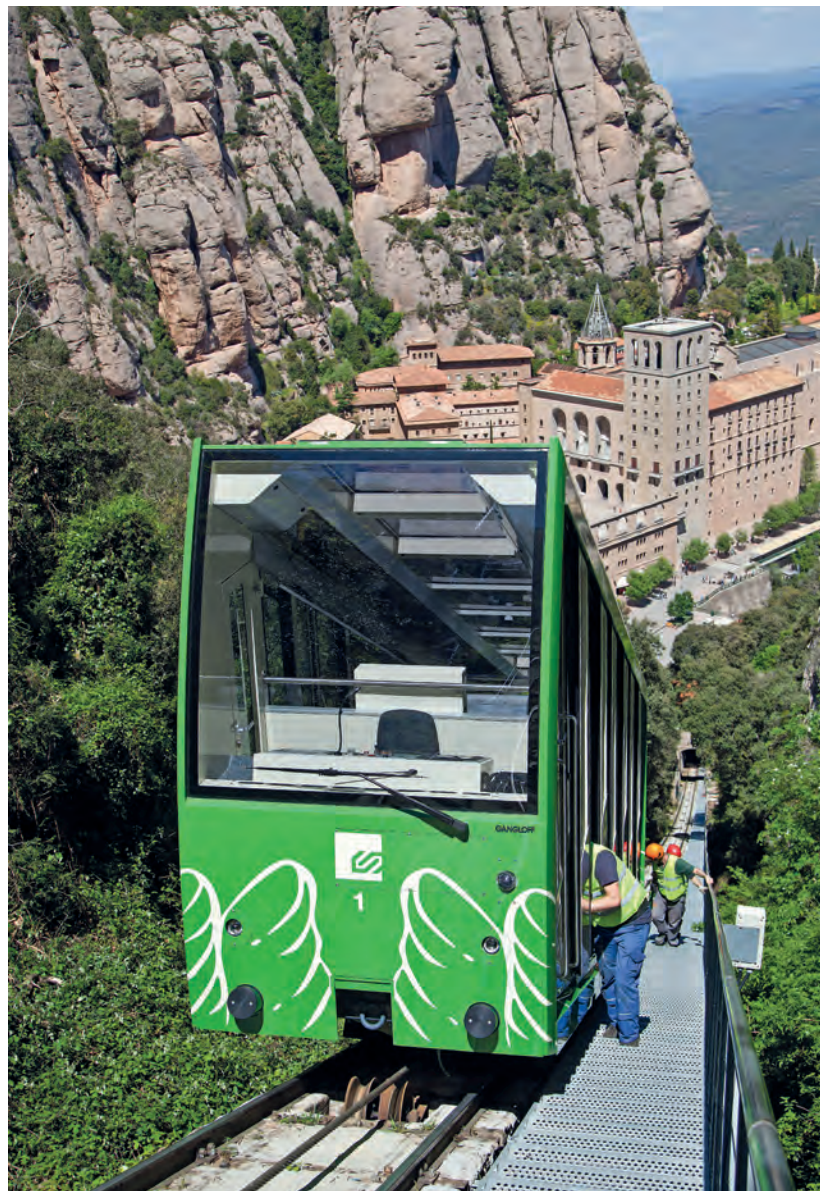
INSTAL·LACIÓ D'UN DELS NOUS COTXES DEL FUNICULAR DE SANT JOAN | FGC/RAMON VILALTA
