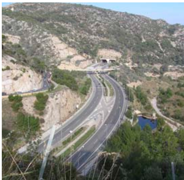
LA C-32, AUTOVÍA QUE UNE EL LITORAL DEL BAIX, A LA ALTURA DE GARRAF
