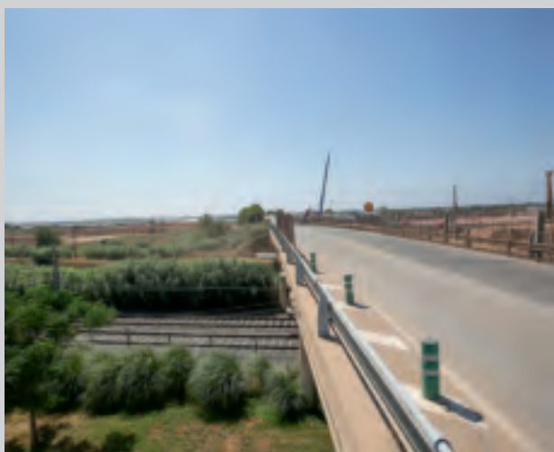
REMODELACIÓ DEL PONT DE LA B-204
