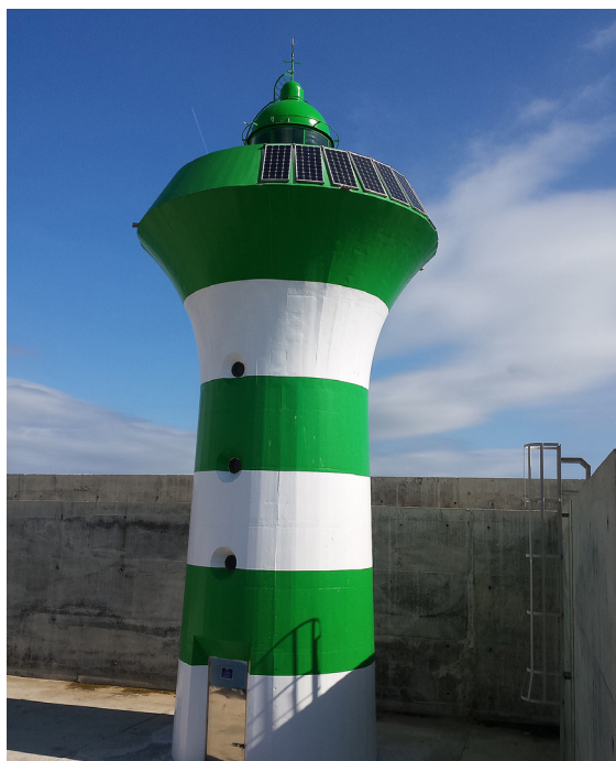
HASTA LOS FAROS SE MODERNIZAN. IMAGEN DE UNO DE LOS DOS NUEVOS FAROS GEMELOS QUE PORT DE BARCELONA HA INSTALADO EN LAS BOCANAS FRENTE A NUESTRA COSTA. PROPORCIONAN MÁS LUZ CON MENOR CONSUMO GRACIAS A SUS LEDS DE ÚLTIMA GENERACIÓN CON ALIMENTACIÓN SOLAR.
