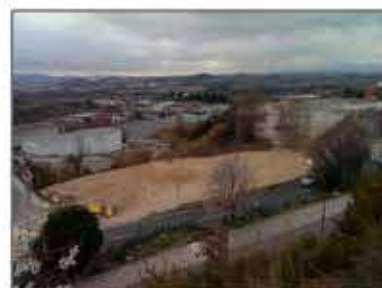
Lote 179 Suelo Industrial en venta en Masquefa
