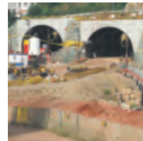
TÚNEL DE LA VARIANT EN OBRES
