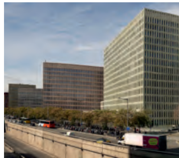
LA TERMINAL 1 DE EL PRAT, A LA IZQUIERDA, HA PERMITIDO UN CRECIMIENTO EXPONENCIAL DEL TRÁFICO AÉREO EN LA INFRAESTRUCTURA AEROPORTUARIA. A LA DERECHA, ACTUAL CIUDAD DE LA JUSTICIA DE BARCELONA Y L'HOSPITALET
