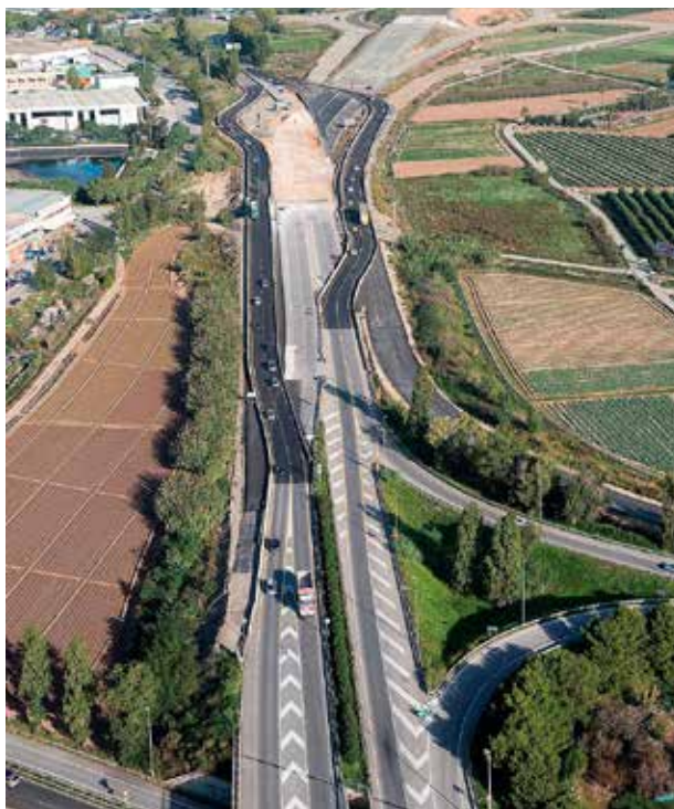
DESVIAMENTS PROVISIONALS PENDENTS DE L'OBRA | TERRITORI I SOSTENIBILITAT
