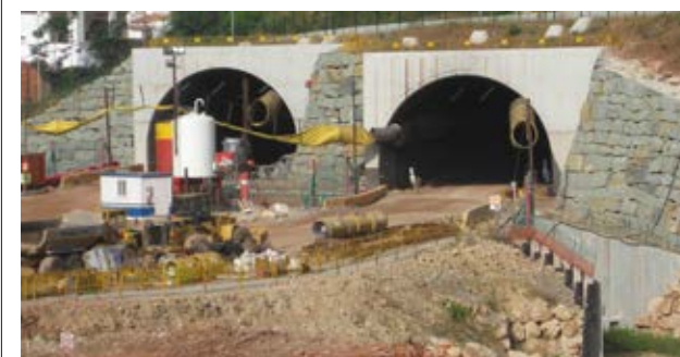
OBRES DE LA VARIANT DE VALLIRANA | ARXIU
