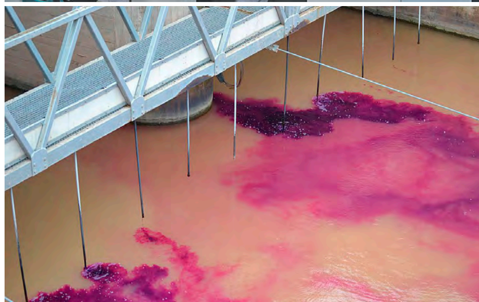
IMÁGENES DE LA ETAP LLOBREGAT, EN ABRERA. LAS DIFICULTADES DEL LLOBREGAT HAN CONVERTIDO LA PLANTA EN UNA DE LAS MÁS COMPETENTES DEL SECTOR, DE REFERENCIA A NIVEL INTERNACIONAL | I.C.
