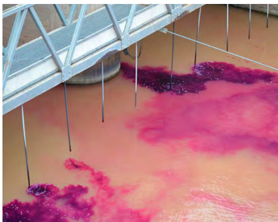
ESTACIÓN DE POTABILIZACIÓN DEL LLOBREGAT, EN ABRERA
