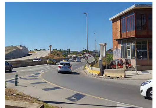
LAS OBRAS DE LA VARIANTE DE LA C-245 REABREN EL ACCESO SUR A SANT BOI ANTE LA PARÁLISIS DE LAS OBRAS
