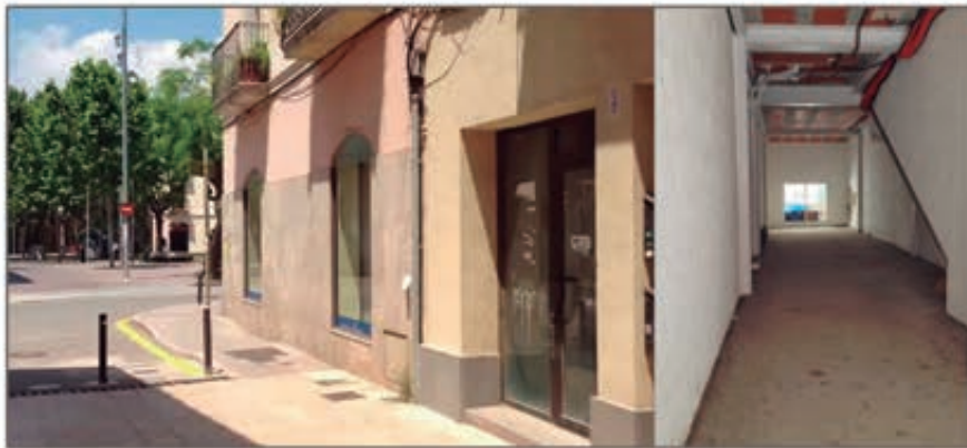
Lote 98 - Local comercial en alquiler en Sant Boi de Llobregat Ubicado en la zona centro del municipio, junto al Ayuntamiento
