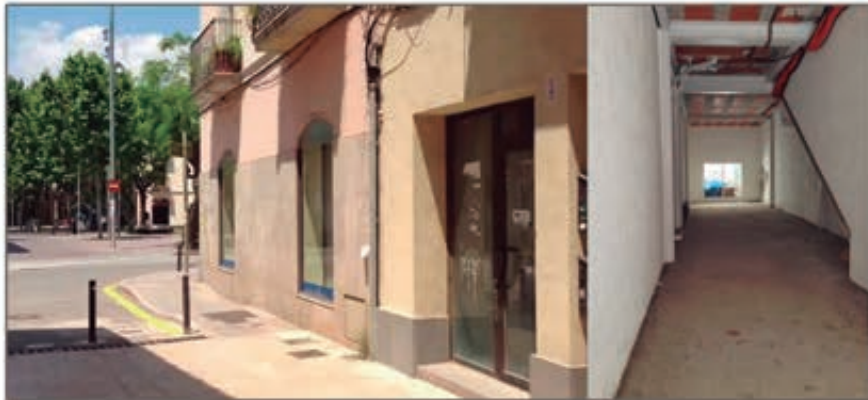
Lote 98 - Local comercial en alquiler en Sant Boi de Llobregat Ubicado en la zona centro del municipio, junto al Ayuntamiento
