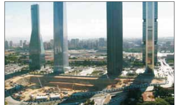
Las obras de construcción del CICCM, junto a las cuatro torres.
