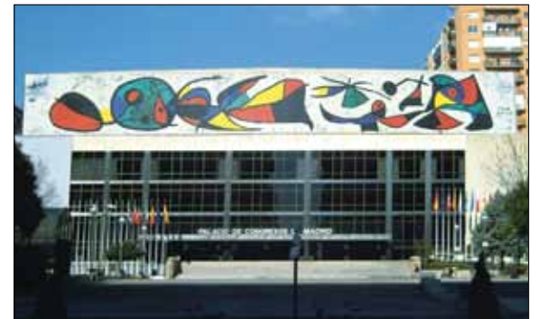
El Palacio de Congresos de Madrid necesita una remodelación.
