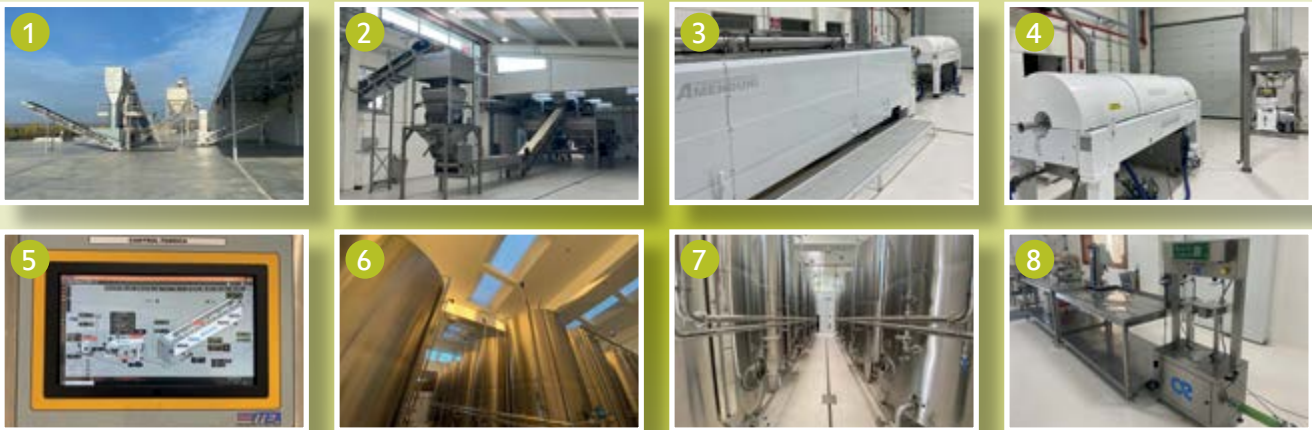
Instalaciones de la almazara ecológica de Cortijo el Puerto en Lora del Río (Sevilla). De izqda. a dcha., y de arriba a abajo, patio y zona de recepción y almacenamiento con maquinaria de Asigran (1 y 2); zona de extracción con línea completa de Amenduni (3 y 4); SCADA de supervisión, control y adquisición de datos de Automatismos ITEA (5); bodega con depósitos de acero inoxidable de Herpasur-Secovisa (6 y 7); y línea de envasado con equipo de llenado fabricado por Autelec (8).
